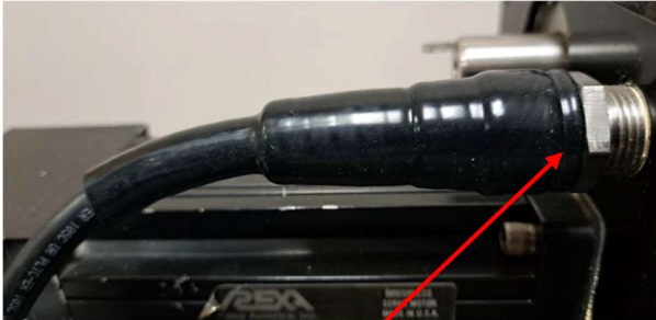
Figura 3C – Tubulação pequena após
