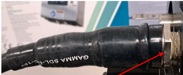
Figura 2B – Tubulação grande após encolhimento
